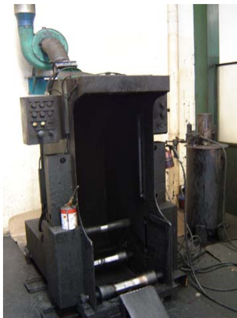
Figura 14 – Cabina de pintura
