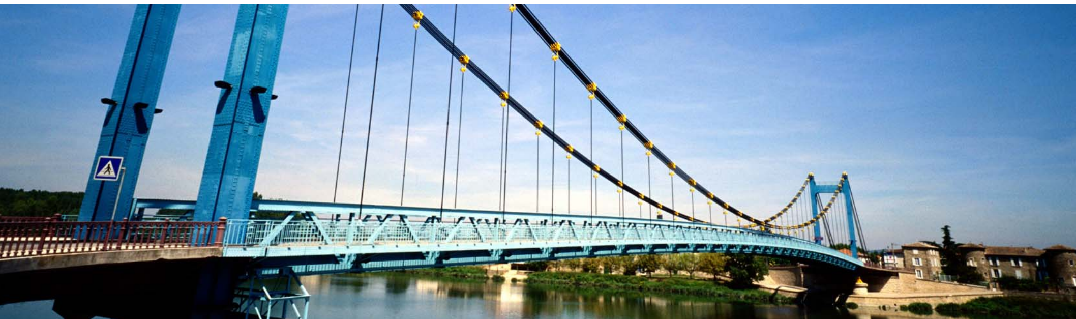
Ponte Suspensa sobre o Rhône, Lyon, França
